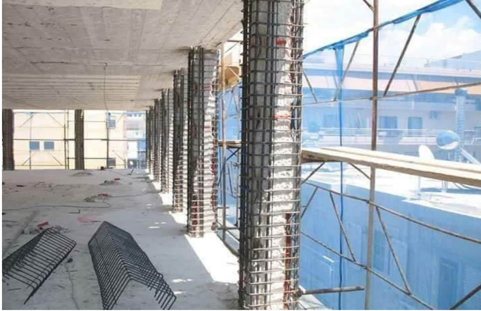
الشكل (4-1): شكل تطويق الأعمدة بالقميصان الخرسانية.
