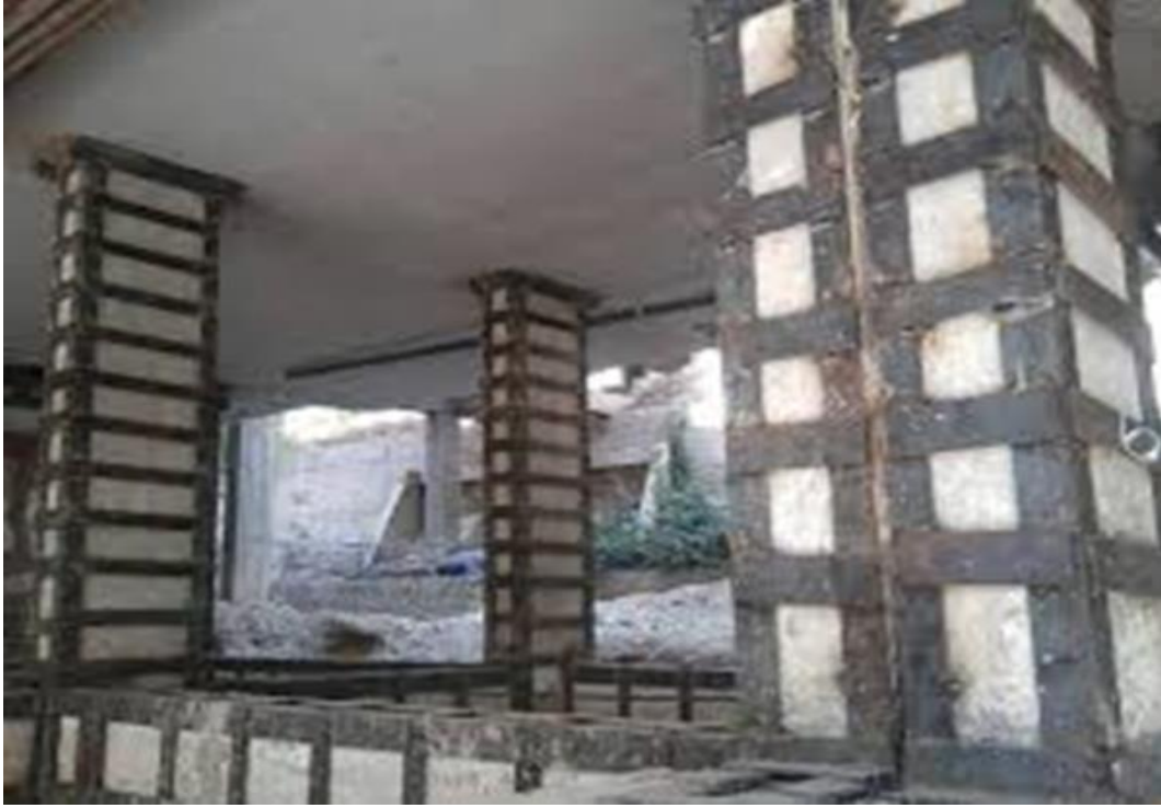
الشكل (10-1): صورة لتدعيم الأعمدة والشيئناجات بالزوايا والمبسطات الفولاذية.
