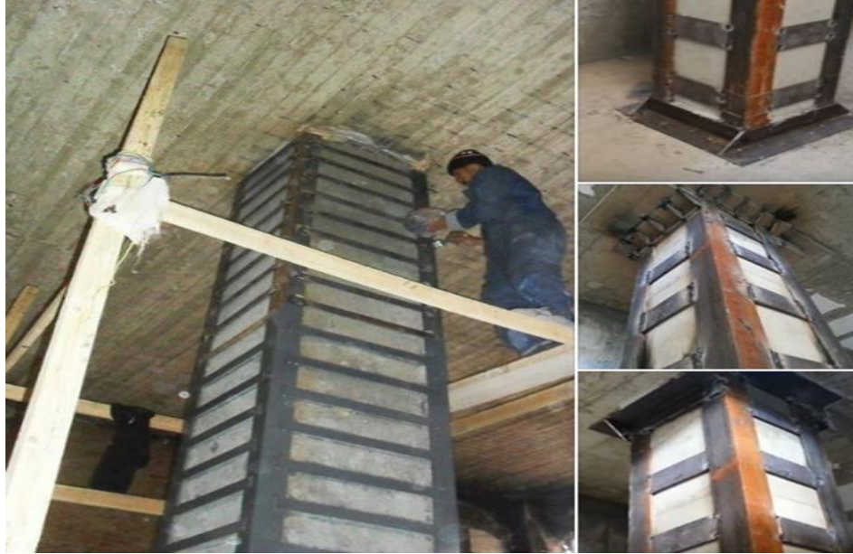
الشكل (7-1): صورة لأعمدة خرسانية مقواة بهياكل فولاذية.
